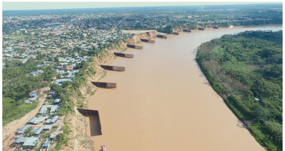
Una solución hidráulica de muy bajo impacto ambiental y diseñada a la medida del problema se desarrolló en una defensa ribereña en el sector La Pastora, en Madre de Dios. Con esta obra de infraestructura se estabilizó la base de un acantilado y se evitó poner en riesgo la integridad de un tramo de la Carretera Interoceánica Sur y se aseguró la conectividad de la población de Madre de Dios con el resto del país.
