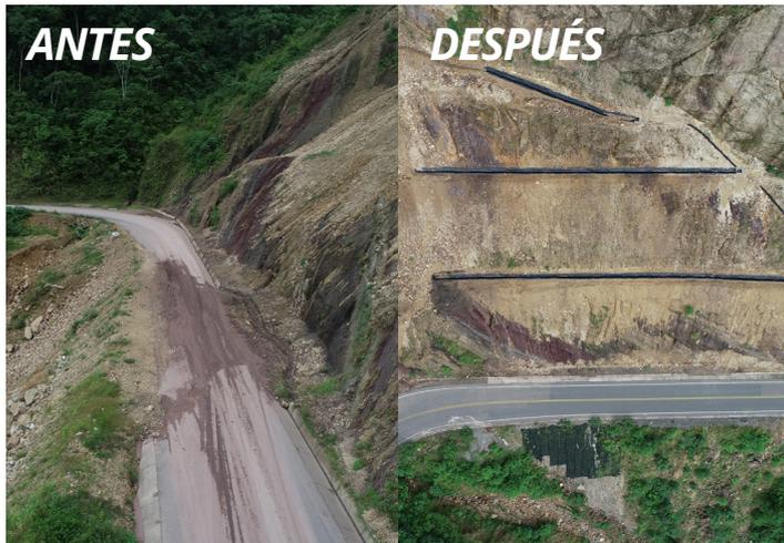
Durante la temporada de lluvias del año 2020, en el distrito de Inambari se presentó un deslizamiento del talud superior de la plataforma de la carretera en el Km 245 de la Carretera Interoceánica Sur, tramo 2.
