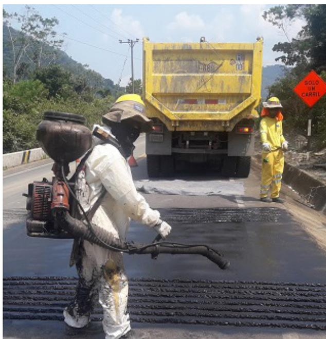
Los trabajos de mantenimiento de emergencia tomaron dos meses, e incluyeron la ampliación de la vía por el carril izquierdo. Se iniciaron los trabajos con la colocación de gibas para reducir la velocidad de los vehículos. Luego se hizo el ensanchamiento de la vía a través de un corte en el talud, mejoramiento del acceso generado con material filtrante, sub base, base y mezcla asfáltica en frío. Posteriormente se hicieron cunetas de concreto.
