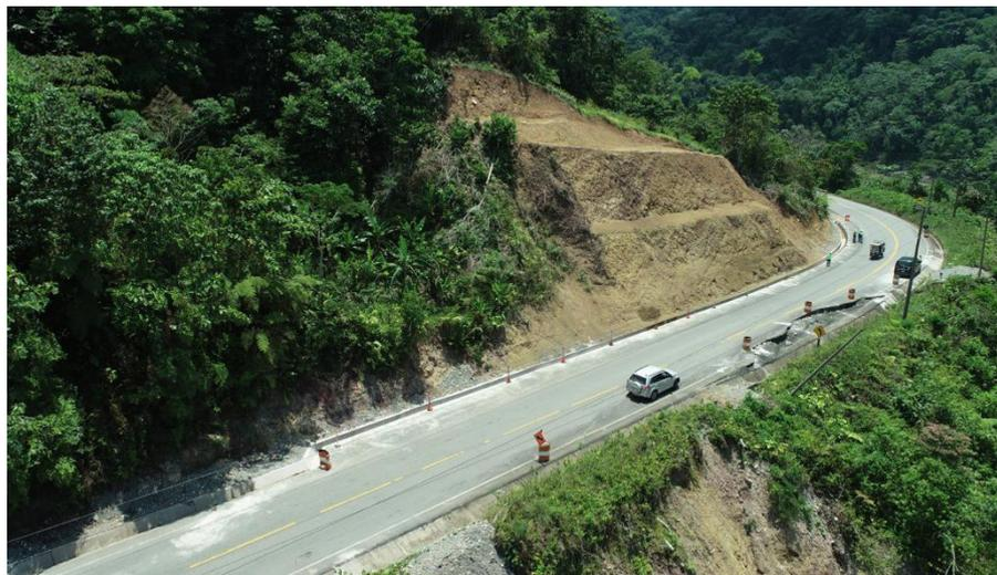
Estas fisuras generaron la reducción del ancho de la calzada, dificultando el tránsito vehicular por ambos carriles y convirtiéndose en un peligro para los usuarios de la vía.
