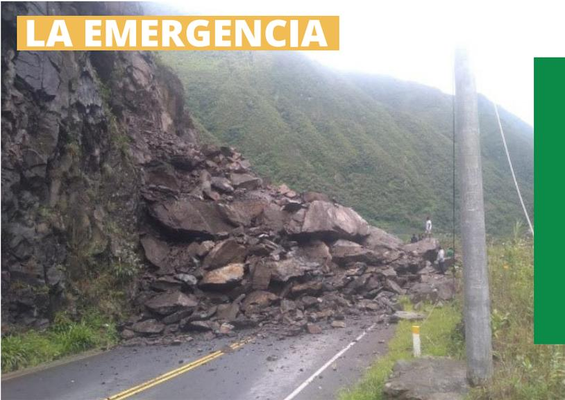
El 15 de octubre de 2018, las lluvias estacionales produjeron un gran desprendimiento de rocas que causó daños severos en la carpeta asfáltica. Además, un gran grupo de rocas quedó expuesto de manera que existía riesgo inminente de un nuevo derrumbe, que podría ocasionar accidentes a los usuarios.
