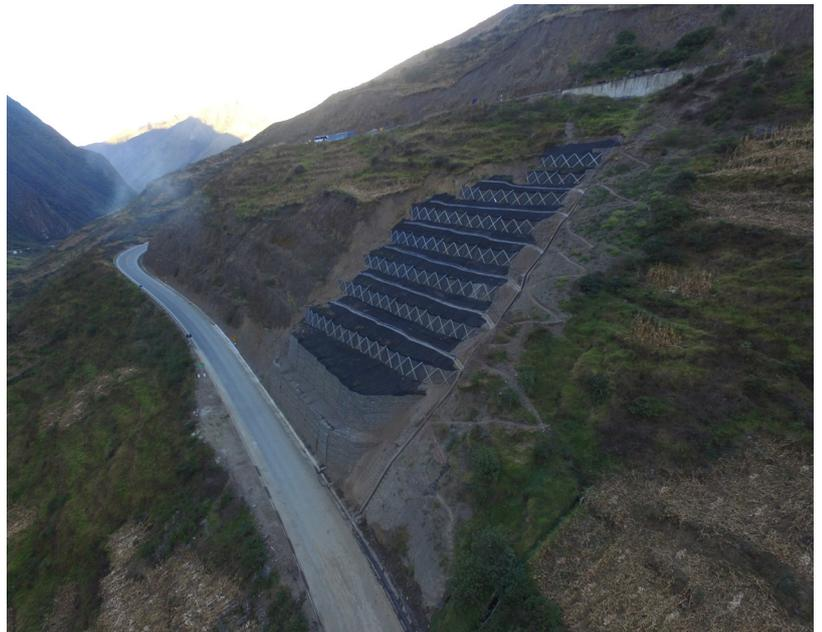
El sistema Erdox tiene la ventaja de ser una solución de tipo permanente, por lo que, una vez instalado, se evita cualquier riesgo de derrumbe. Además, no requiere de un mantenimiento o monitoreo específico y puede ser utilizado en todo tipo de terreno, por lo que puede ser colocado en costa, sierra o selva.
